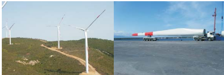
Parco Eolico del Grighine Sardegna 43 turbine da 2.3MW
