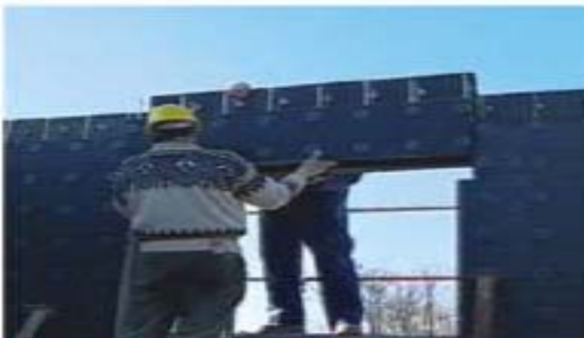
Casseri muro, voltino, sottofinestre
