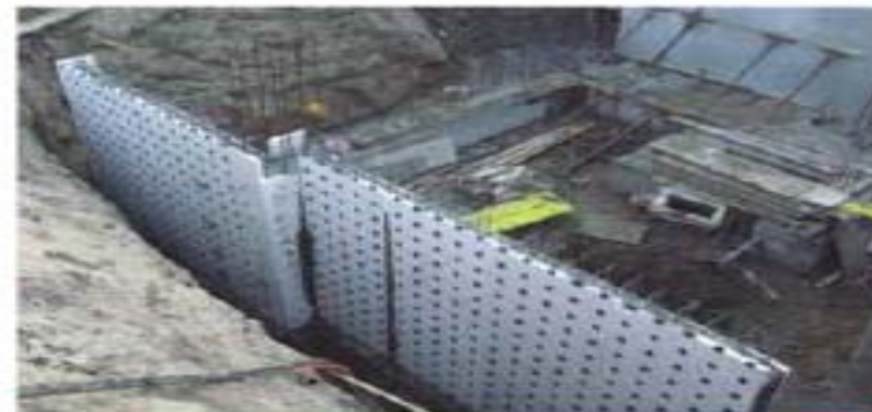
Montaggio casseri muro
